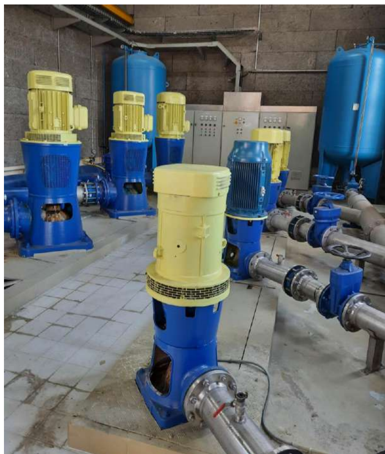
Figure 7 : Pompes de distribution des eaux traitées par l'usine de Maquens
