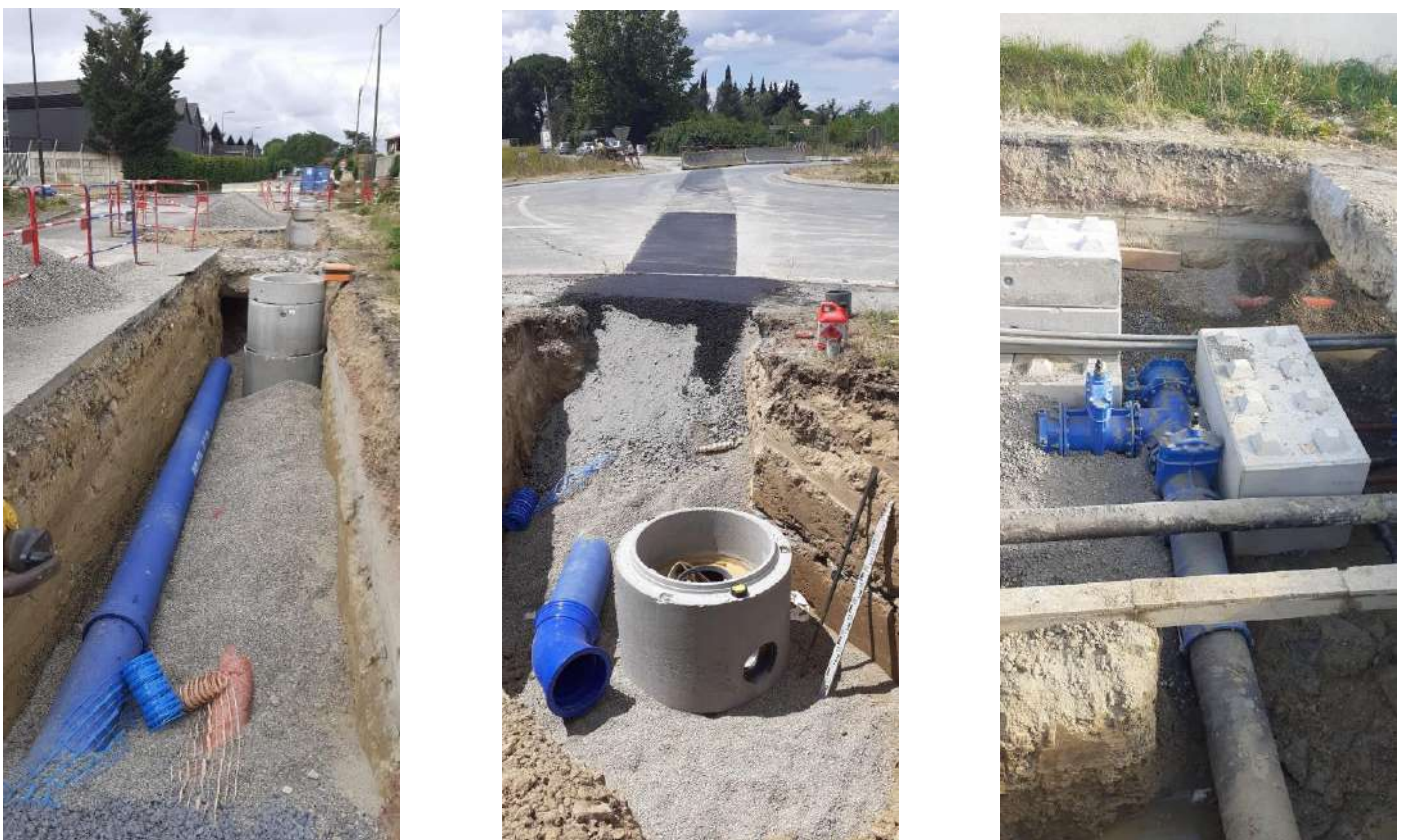
Figure 1 : Photos des travaux d'extension de réseau pour ROCADEST
