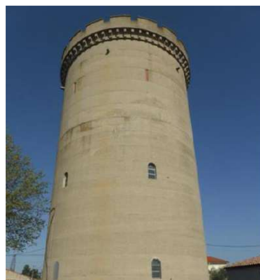
Figure 9 : photo du château d'eau de Pépieux
