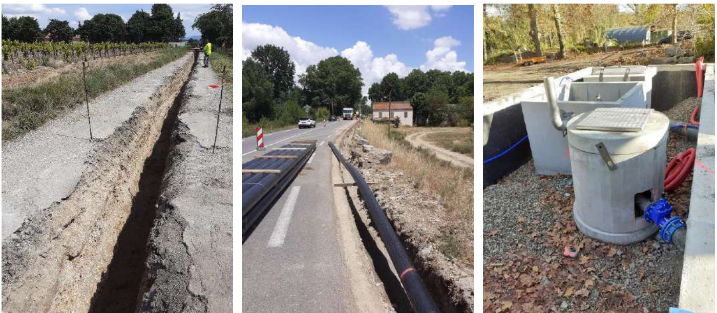
Figure 14 : Photos des travaux de raccordement de Villalier à Carcassonne Saint Jean
