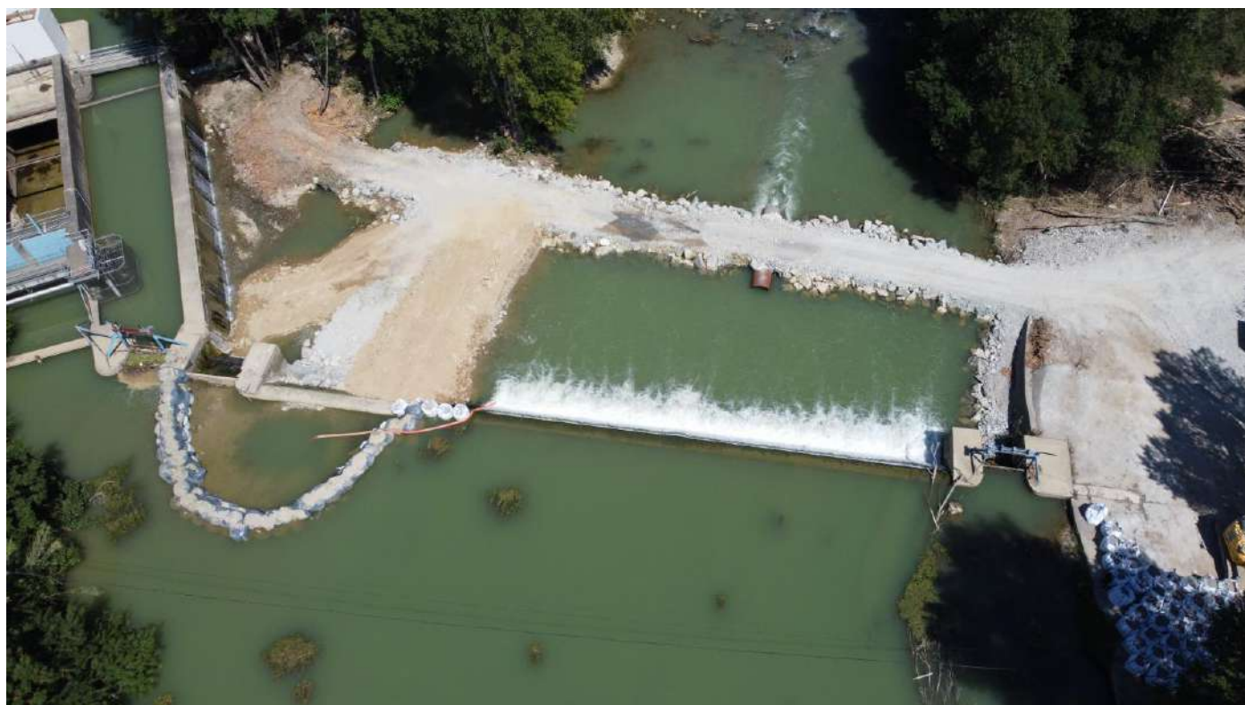
Figure 13 : photo du seuil de Maquens lors de travaux de restauration de la continuité écologique à l'été 2021
