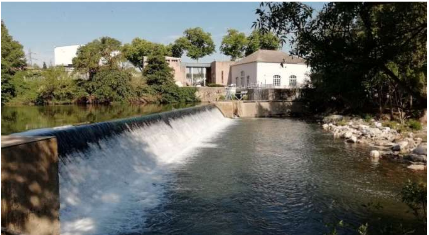
Figure 11 : photo du seuil de Maquens et de l'usine de traitement de l'eau potable
