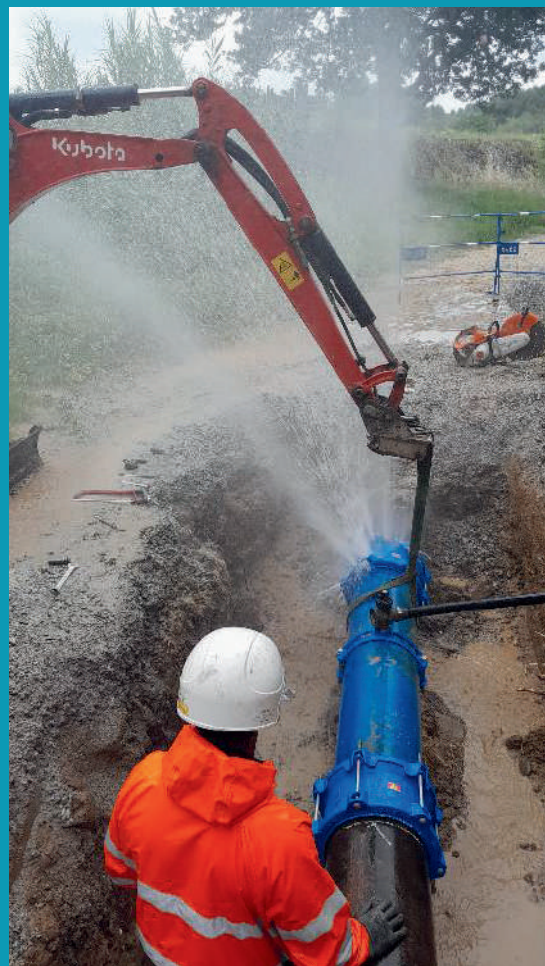
Intervention sur une fuite
