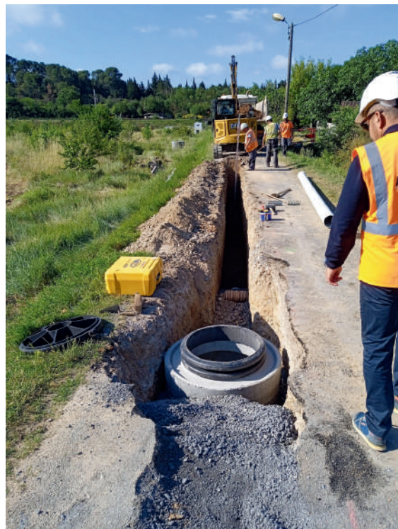
Travaux de raccordement
